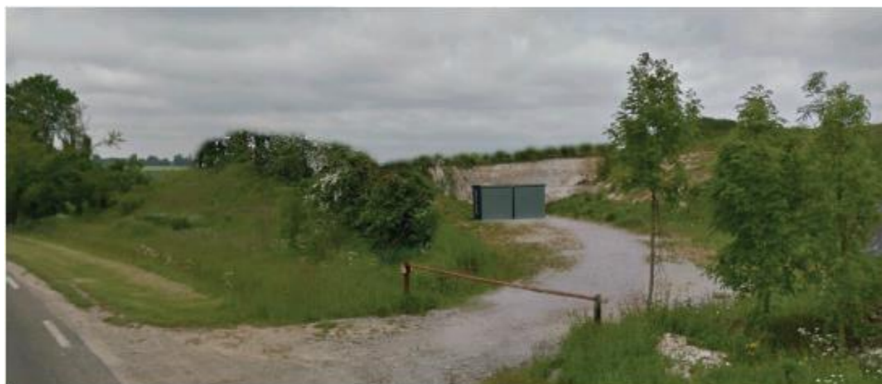
Intégration des deux postes de livraison
